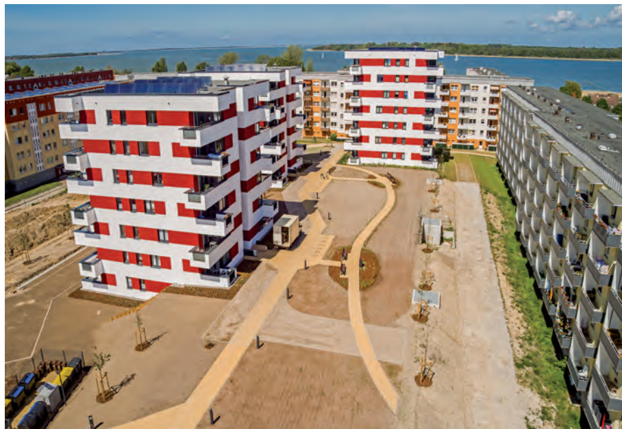
Wohnhäuser Berliner Straße 6 und 7 fertiggestellt
