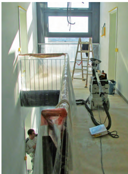
Restarbeiten im Treppenhaus
