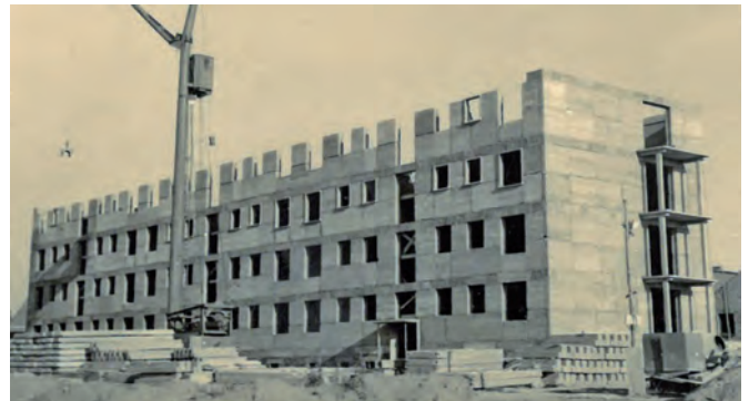
Bukarester Straße in Großblockbauweise gefertigt
