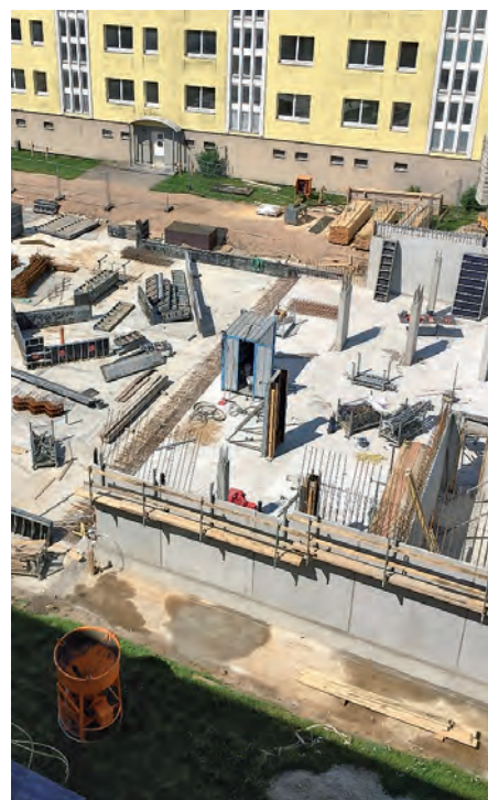
Bauvorhaben „Boddenwiese“, Bodenplatte Haus 5
