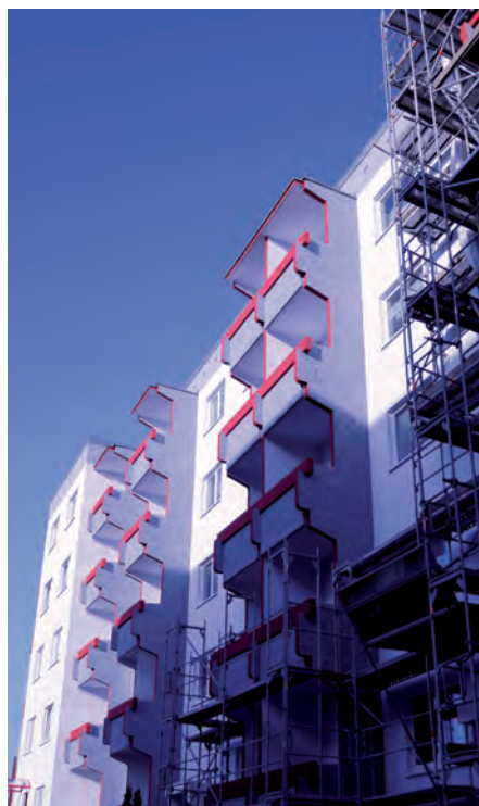
Mittelweg 46-52, Sanierte Fassaden - die Gerüste fallen
