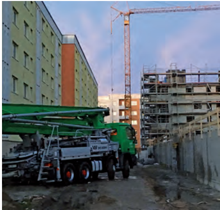
1. Bauabschnitt – planmäßig wächst der Rohbau
