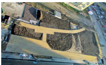
Die Grünanlage über der Tiefgarage nimmt Form an
