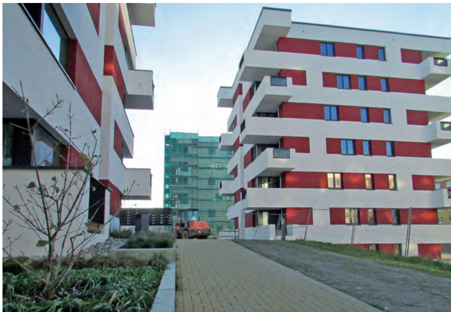
Die Gerüste Berliner Straße 6 sind gefallen, Haus 7 wartet noch verhüllt . . .
