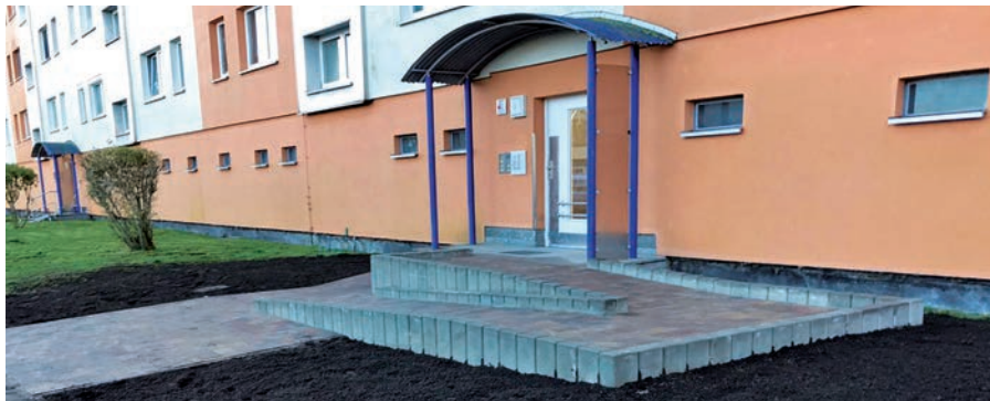
Neu gestalteter Eingangsbereich Minsker Straße 1, mit mieterfreundlicher Rampe für Gehbehinderte und Rollstuhlfahrer
