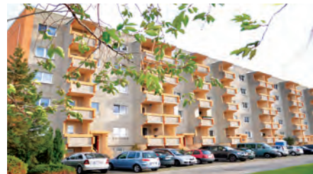
Mittelweg 70-78, Sanierte Fassaden
