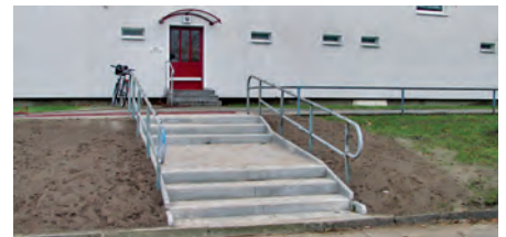
Neue Treppe, Moskauer Straße 14
